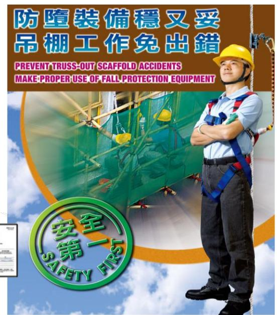
此外，當棚架工人搭建、修改或拆卸懸空式棚架時，必須配帶全身式安全帶；安全帶之懸掛繩(尾繩)要透過防墮器持續扣在獨立救生繩上，並須連接到穩固之繫穩裝置(例如羊眼圈)；竹棚架上之狗臂架要用至少 3 顆繫穩螺絲固定。合資格人士在檢驗懸空式竹棚架時，應確保棚架結構安全才可簽發表格五 (棚紙)並張貼在棚架上，而不可在搭建前簽發。(資料由勞工處及職業安全健康局提供)
