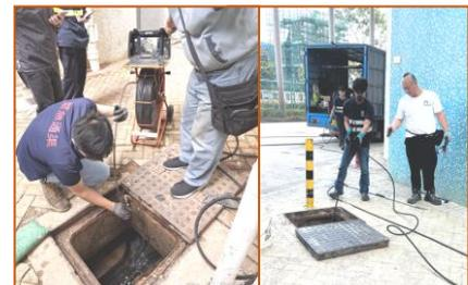
定期檢查及疏通排水渠道；並安排專業承辦商進行全苑高壓通渠及 CCTV 檢測工程
