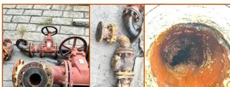
更換老化及損蝕嚴重的供水喉管閘掣組件等裝置，令致系統操控及服務穩定
