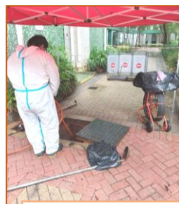
定期檢查及清通排水渠道；並安排專業承辦商進行全苑高壓通渠及 CCTV 檢測工程
