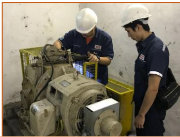
原廠品牌承辦商定期檢查及保養升降機，並保持妥善維修狀況及安全操作服務
