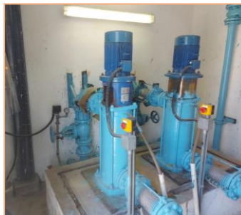
更換變頻式節能馬達食水泵，令致系統控制穩定及節省大量能耗
